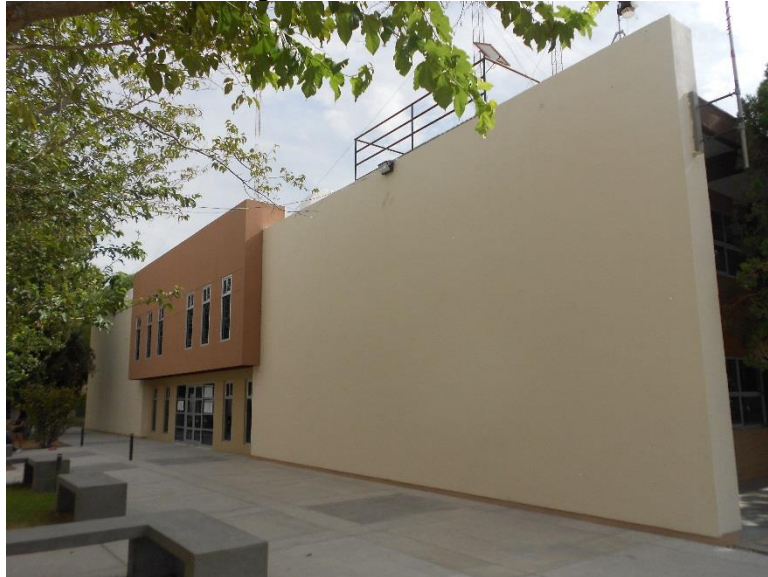
Fotografía 3. Edificio "E" del IIT
