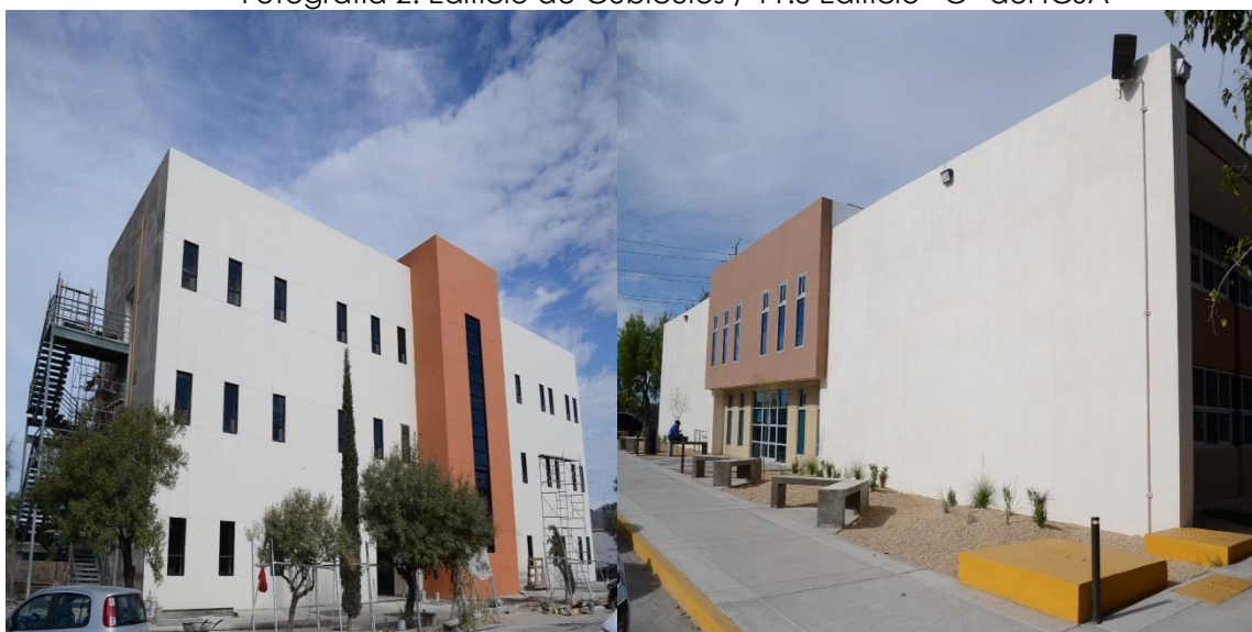
Fotografía 2. Edificio de Cubículos / 11.3 Edificio "C" del ICESA
