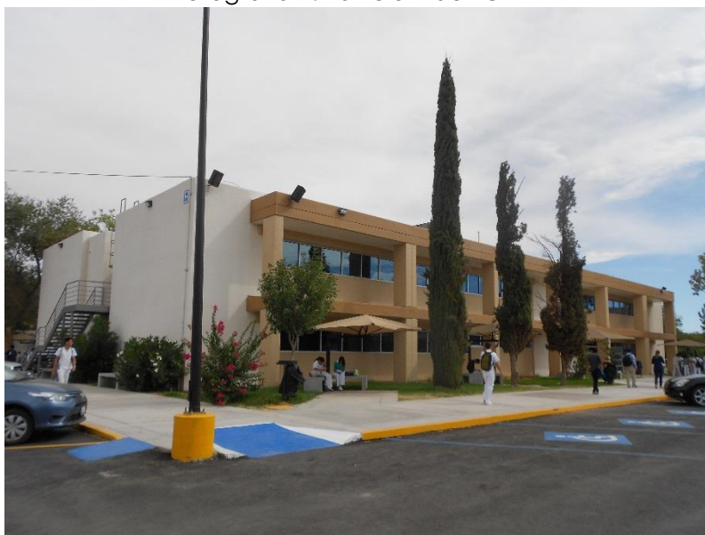
Fotografía 1. Edificio B del ICB
